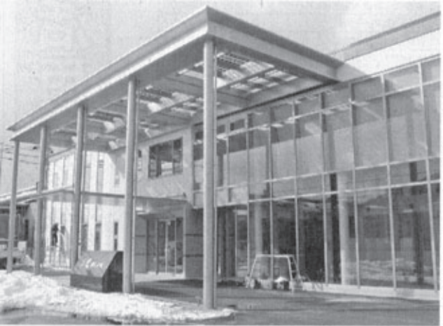
三光の太陽光発電パネルを設置した社屋
