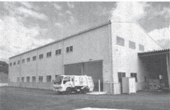
「ジ ンカイ・グ リーンファ クトリ 塩江」の外 観（B） 導入してい るクリーン コンボ（C）
