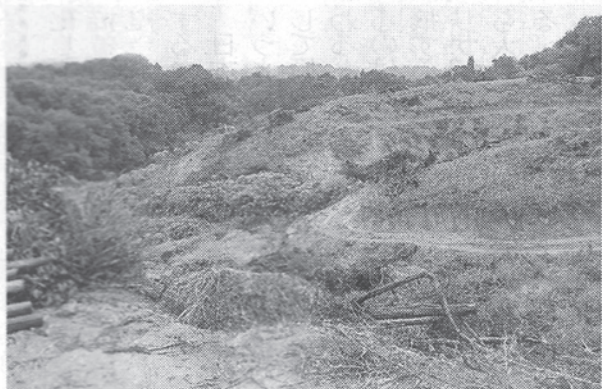
第3期工事の現場
