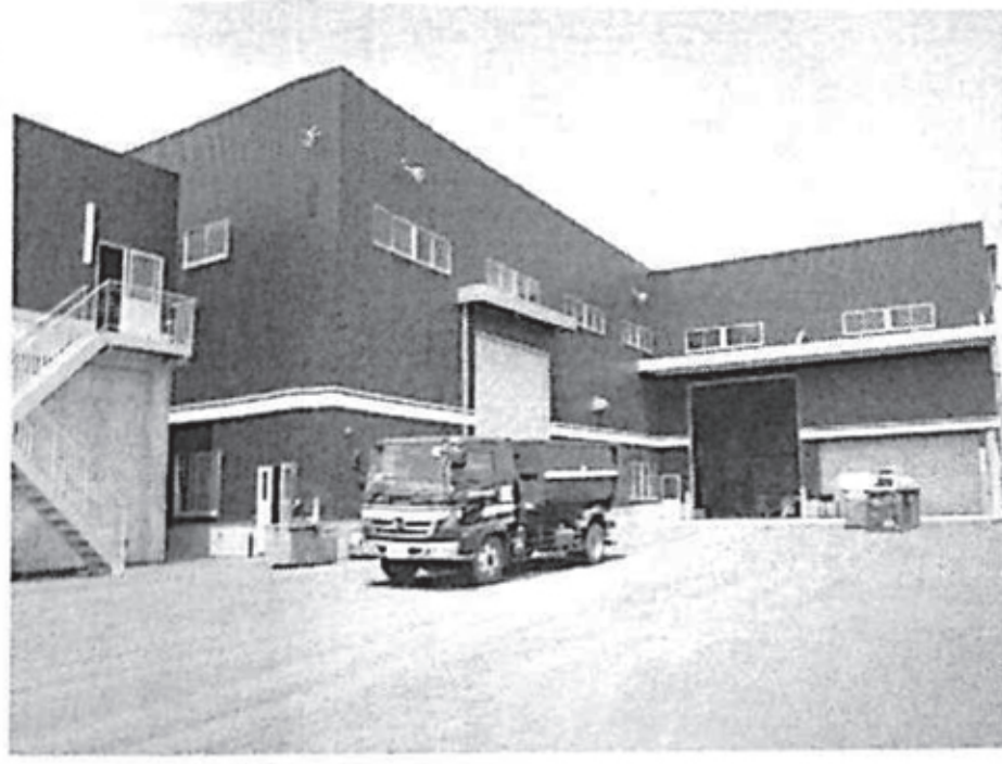
北上市南部工業団地に工場を新設した
