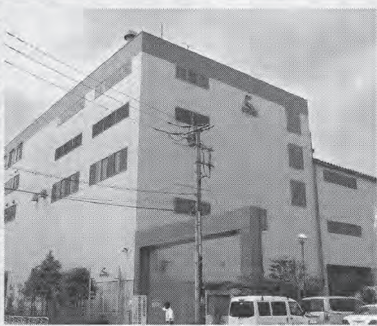
完成した東京工場
