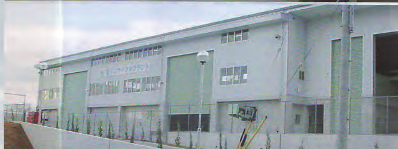
上:選別精度の向上が利益を生む 下:破砕・選別を行う豊川リサイクルプラント
