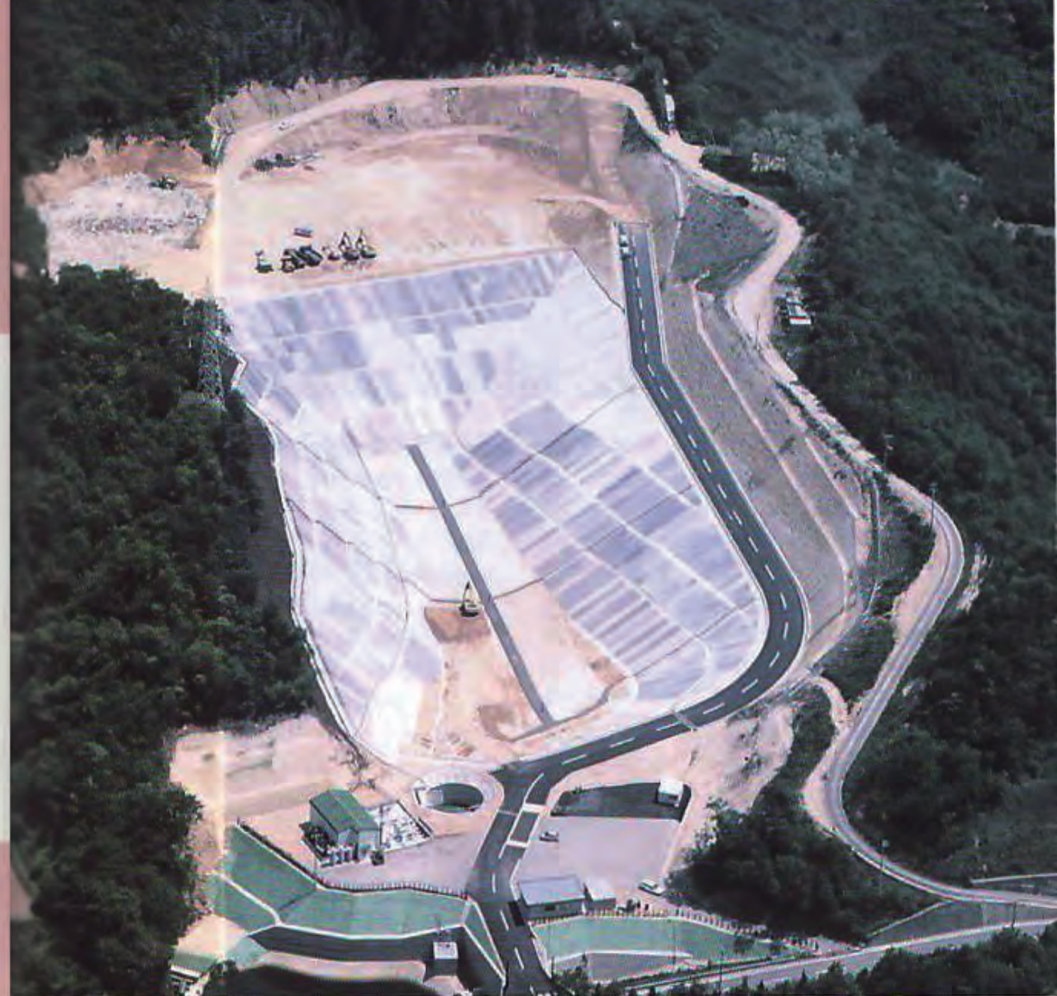
下和田産業廃棄物処分場（香川県綾川町）
