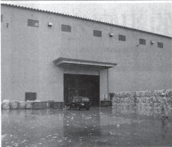
新設した第4工場
