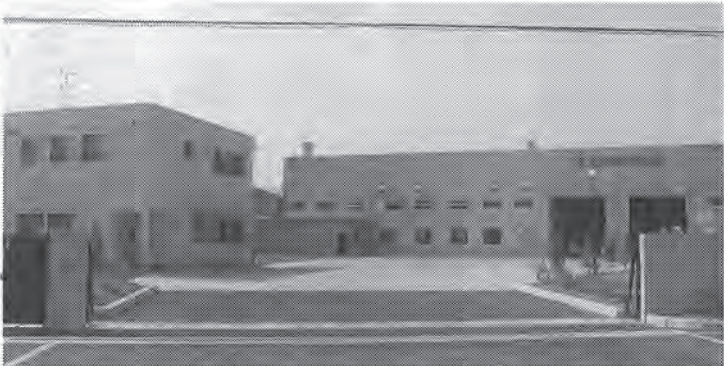
本格稼働に入った岸之浦工場
