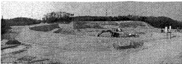
増設工事後の石川処分場
